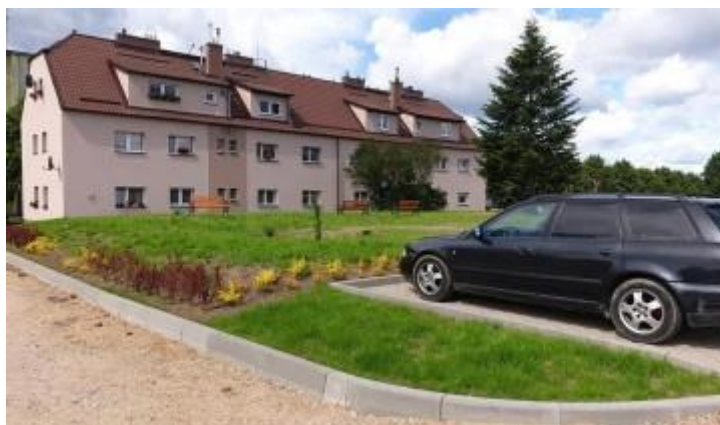
Zdjęcie nr 4. Zagospodarowanie terenu przy ul. Milej 1-3 oraz 5-7
