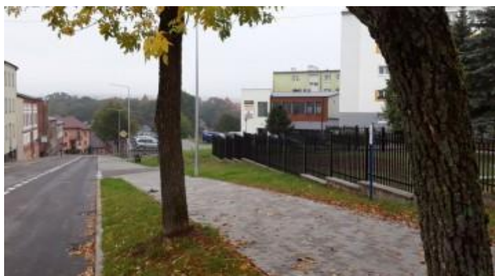
Zdjęcie nr 5. Przebudowa ulicy Pochylej
