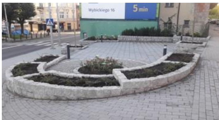
Zdjęcie nr 6. Przebudowa ulicy Pochylej
